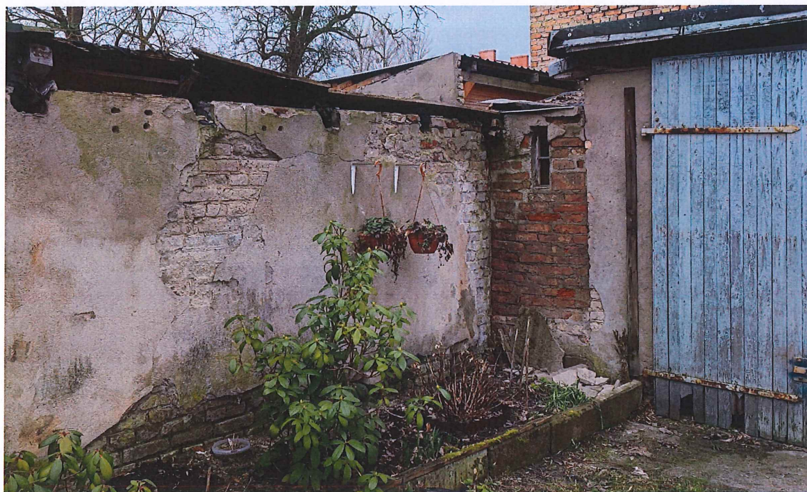
Fot. 3. Spękana ściana z odpadającym tynkiem
